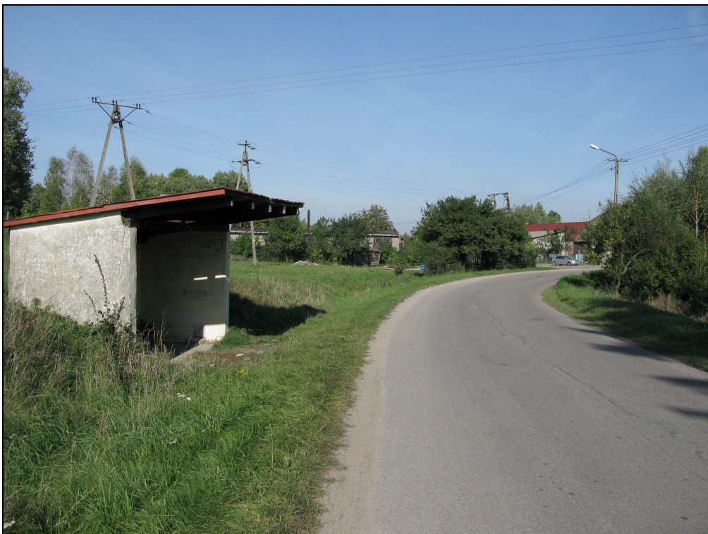
Fot. 2. Wiata przystankowa
