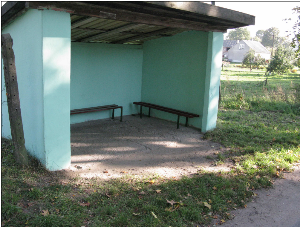
Fot. 3. Istniejąca wiata przystankowa
