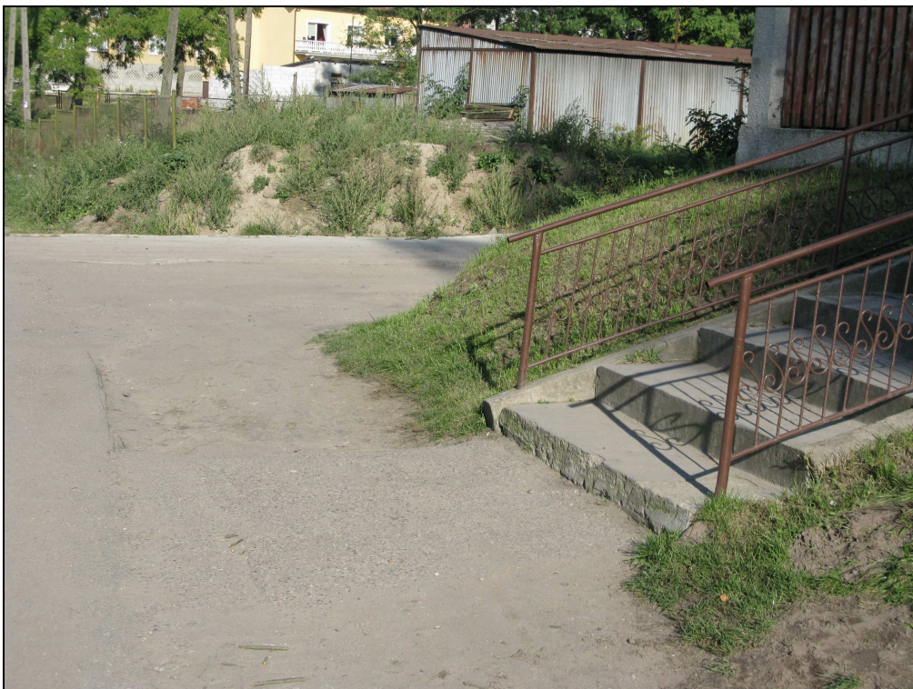
Fot. 2. Zjazd w km 0+052,01 i schody do sklepu
