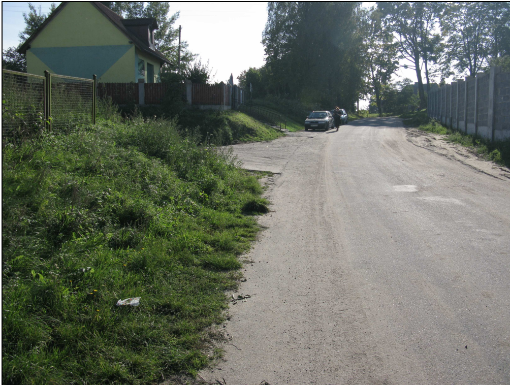
Fot. 1. Droga nr 1259N – widok w kierunku drogi nr 542
