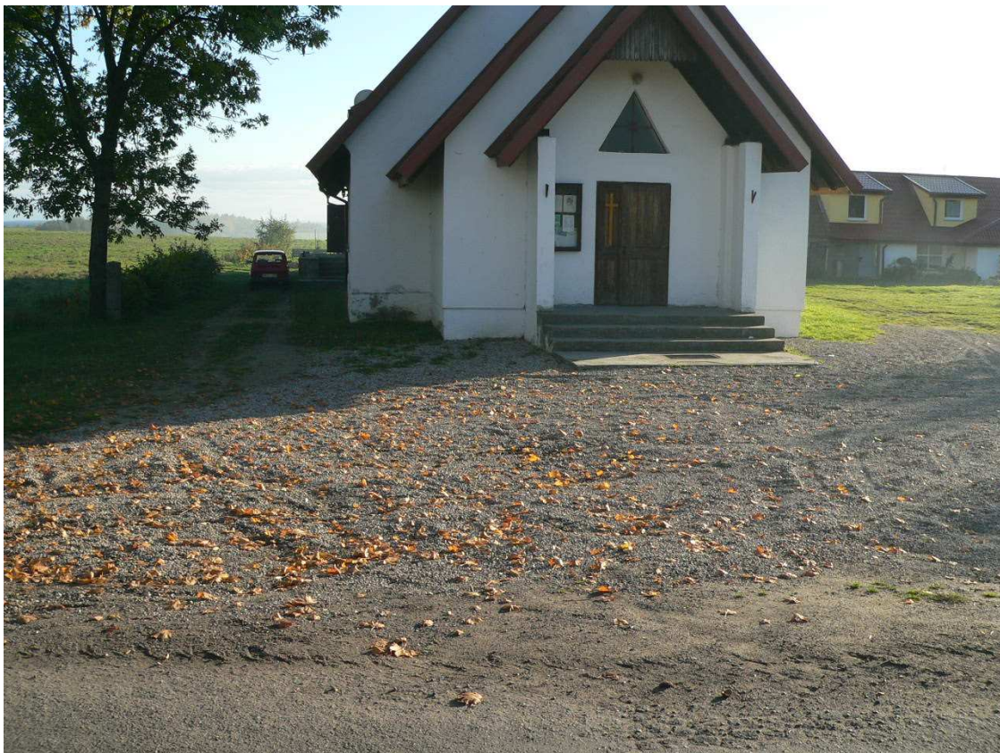
Fot. 4. Miejsce zakończenia chodnika po lewej stronie
