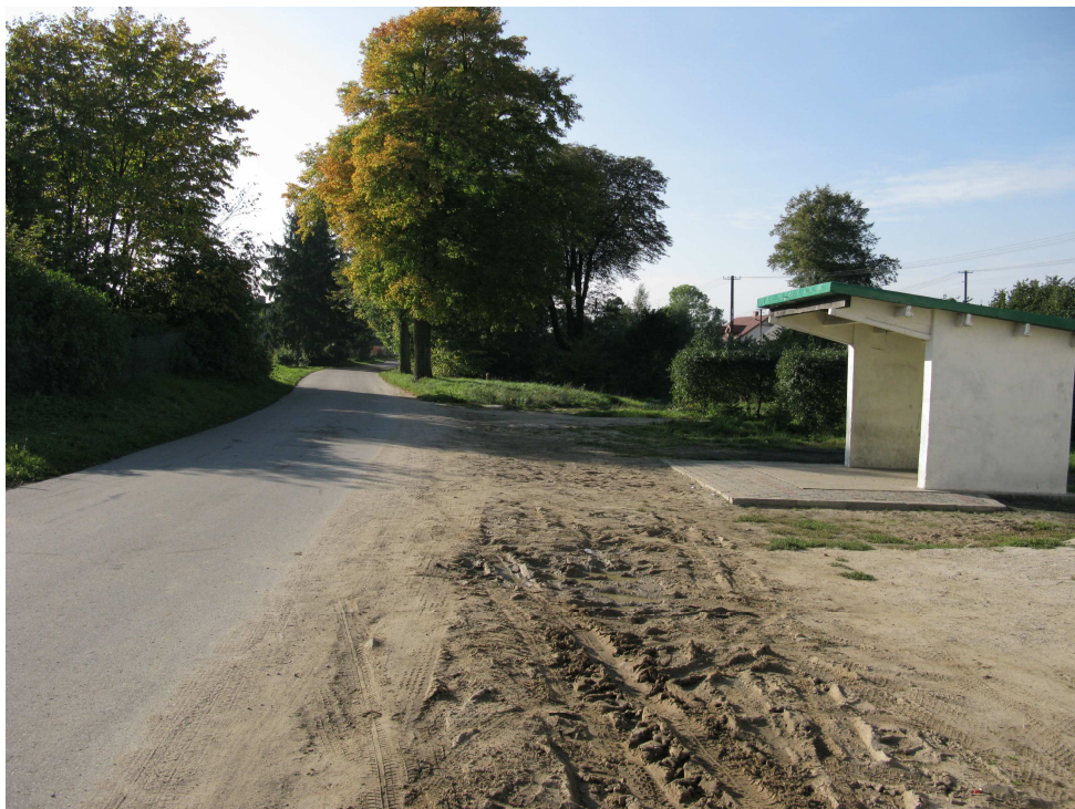
Fot. 1. Droga nr 1224N – widok w kierunku projektowanej zatoki autobusowej.
